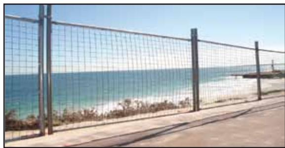
Palissade suivant modél dimension 3m x 2m cadre en tube rond diamètre 42 plus tube rond 25 fond avec grillage en métal déployé.
