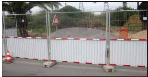
Palissade galvanisé, suivant model dimension: 2mx2m, cadre en tube rond diamètre 42 plus tube rond diamètre 25, fond avec grillage en MAIL 300, dimension 2mx2m habillé avec une tôle ondulée de 2m x 1m.
