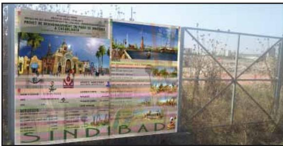
Panneau pour palissade en tôle galvanisée 10/10 dimension 3m x 2m. ossature en cornière 35 x 35 x 3 montant en IPE 80 de 2,50m. et panneau pour palissade avec grillage en métal déployé ossature en cornière 35 x 35 x 3 dimension 2m x 2m.
